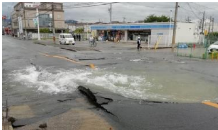
水道管が破断して水が噴き出した道路 (高槻市提供)
