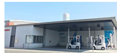
<産業車両用水素供給施設（関空1期島）>
