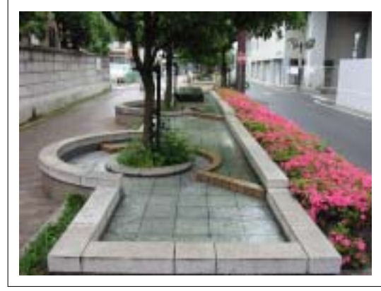
防災用水整備事例 【枚方市駅前せせらぎ水路】
