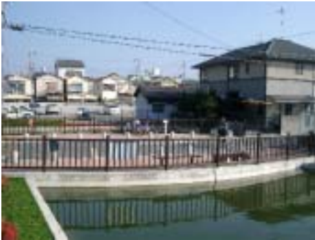
市街地の消防水利整備事例 藤井寺市道明寺地区（H15.3 完成） 都市防災総合推進事業により既存ため池を消防水利に改修
