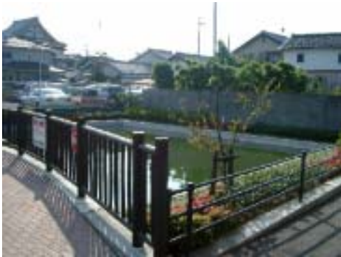
市街地の消防水利整備事例 藤井寺市道明寺地区（H15.3 完成） 都市防災総合推進事業により既存ため池を消防水利に改修
