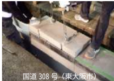
写真 3.3 小型ボックス活用埋設による整備
