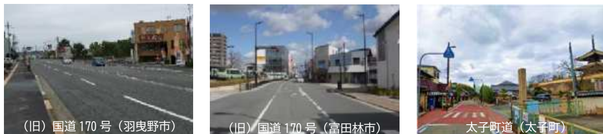
写真 2.3 都市景観に配慮した無電柱化
