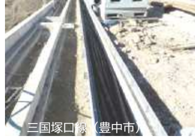
写真 3.3 小型ボックス活用埋設による整備
