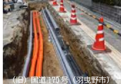
写真 3.2 既存ストック活用方式による整備
