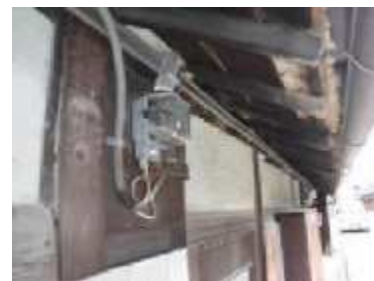
写真 5.3 軒下配線 整備事例 (富田林市 寺内町)
