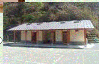
トイレ等改修
