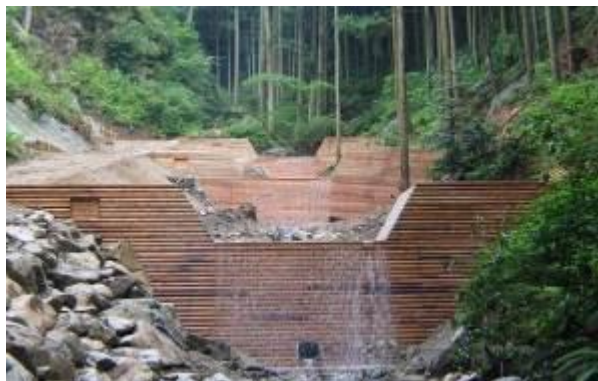
治山ダムの整備
